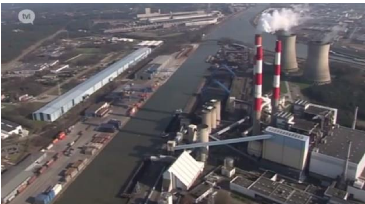
Figuur 1: Elektriciteitscentrale van Langerlo (foto: het Belang van Limburg)
